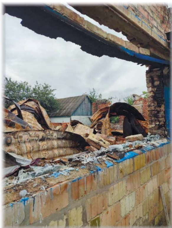
Зруйнована будівля в селі Загальці
