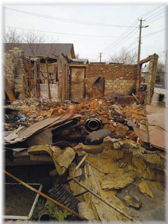
Зруйнований будинок після російської агресії
