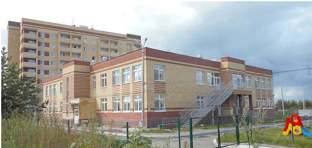
Рис. 1.1. Заклад дошкільної освіти і житловий будинок традиційної будівельної системи з несучими кам'яними стінами
