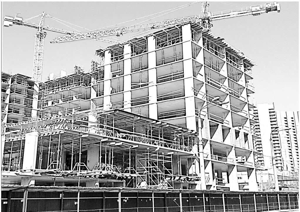
Рис. 1.8. Каркасний монолітний будинок з вертикальними несучими конструкціями у вигляді пілонів (коротких стін).
